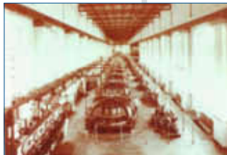
Der Maschinensaal des alten Wasserkraftwerks im Jahr 1899.
